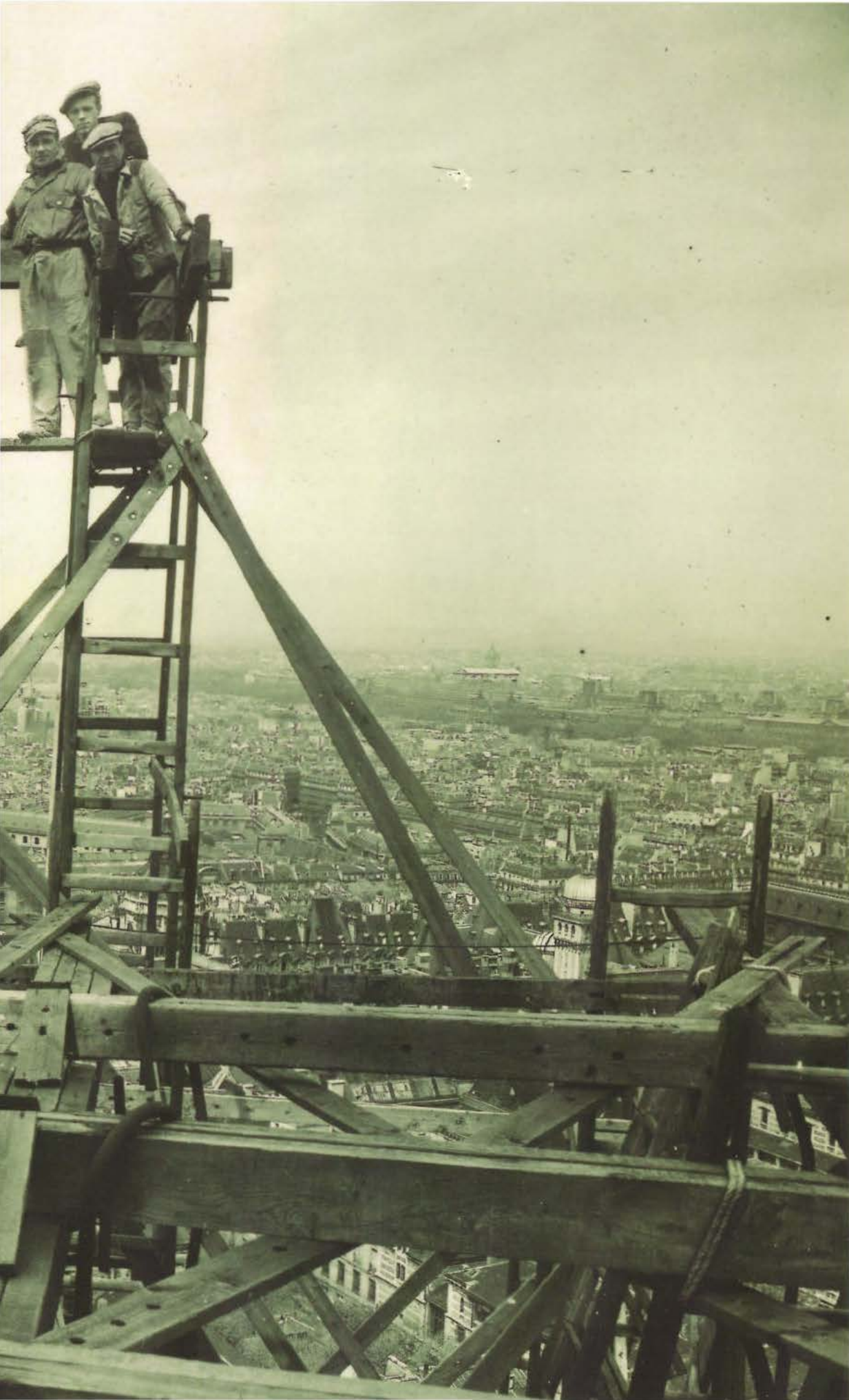
Couvreurs des Plombiers-Fontainiers de Paris dans le ciel de la capitale, au-dessus du Panthéon, dans les années 1930 ; au fond, la tour Eiffel.
